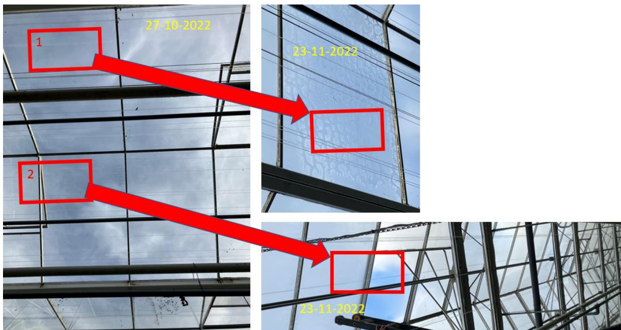
Figuur 12 Grote luchtballen tussen film en glas oppervlak; Aanwezigheid van condens in de ochtenduren.
